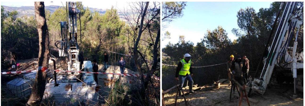
***Illustration 2 – Mise en place de la foreuse au niveau des points des sondages, suivis et Supervise des travaux en étroite collaboration avec le bureau d'étude.***
